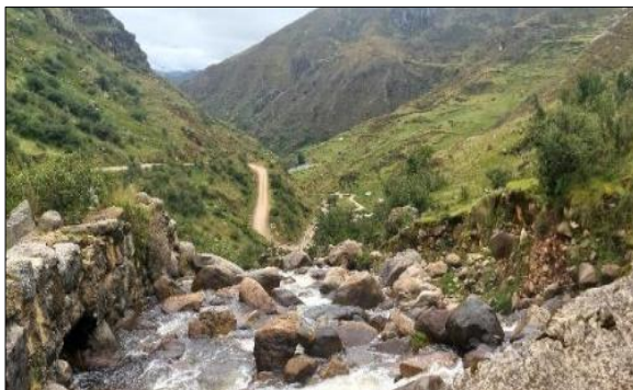
FIGURA N°01: Tramo de la quebrada Huaricolca con un cauce rocoso y un muro de mampostería, mostrando signos de erosión en la margen y la necesidad de limpieza.
