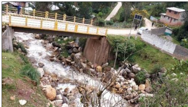
FIGURA N°02: Vista de la quebrada Huaricolca con flujo activo pasando por debajo de un puente vehicular, donde se observa gran acumulación de rocas y material de arrastre.
